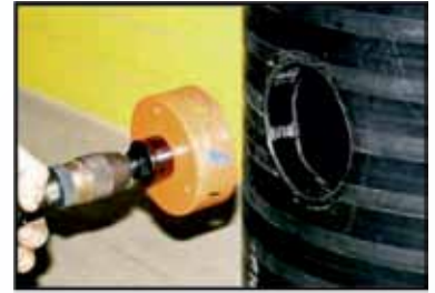
2. Изрежете подходящ отвор в стената на шахтата
